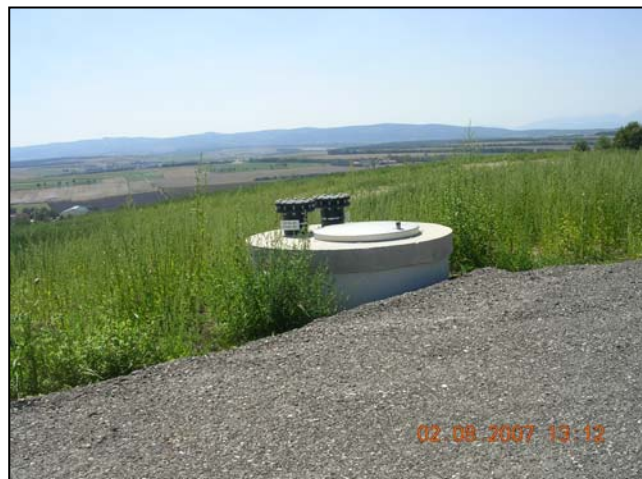
Abb.: fertiger Schacht mit Spülstutzen
