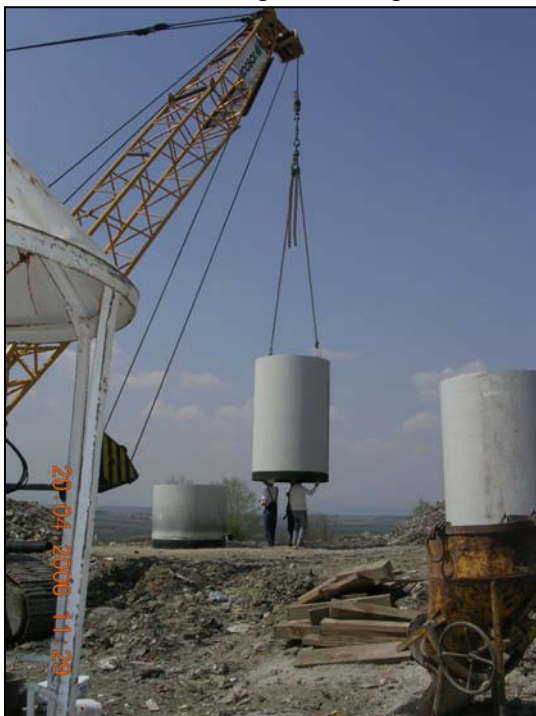
Abb. (links): Einsetzen der Betonschächte
