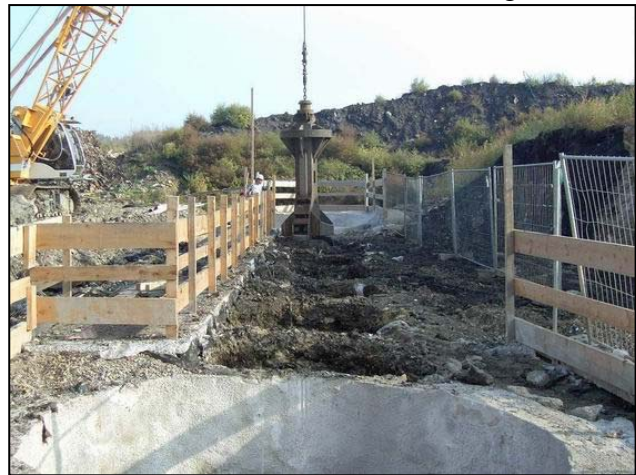
Abb.: offener Grabenverbau
