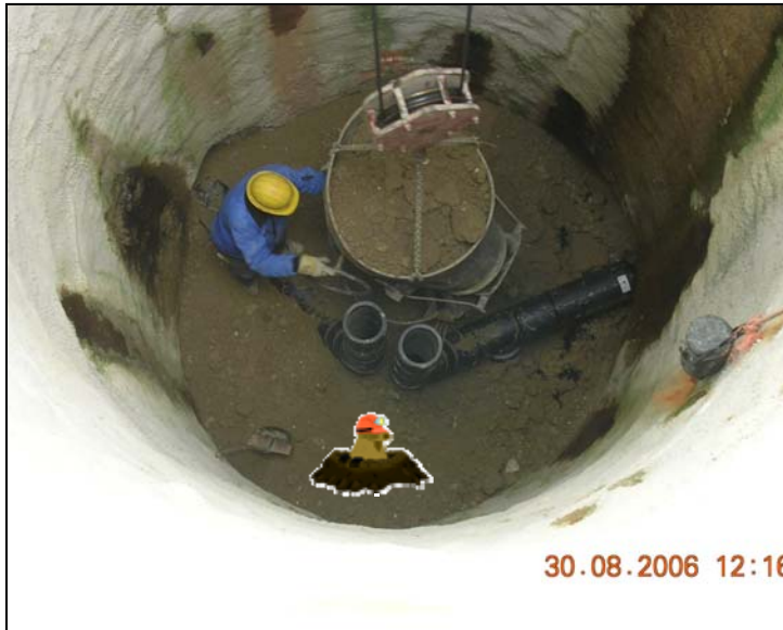
Abb.: Anbinden u. Hochziehen bestehender Drainagen
