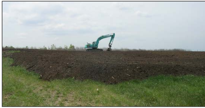
Abb.: Herstellen der Wasserhaushaltsschichte
