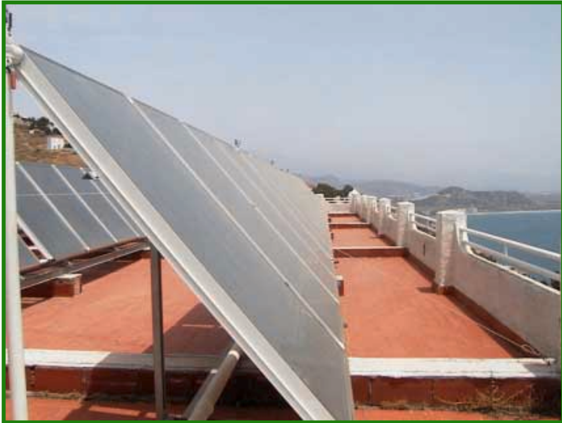
Instalación de placas solares para uno de los edificios
