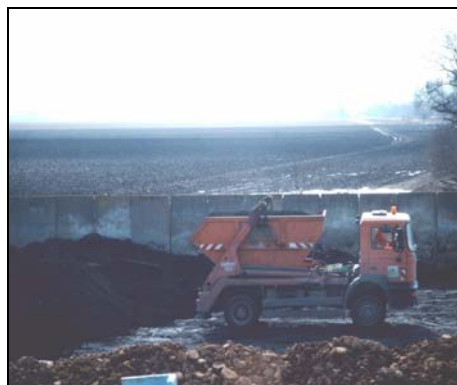
Zwischenlager Warza Anlieferung
