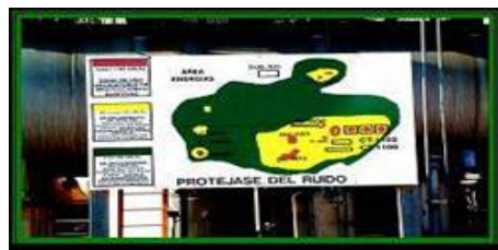
Figura 10: Señalización de protección acústica
