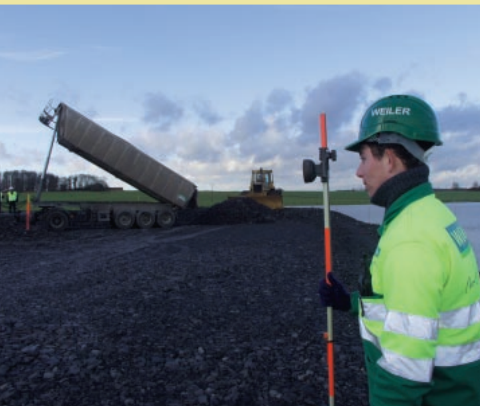
Travaux de remblai à Baudrecourt (France) (La Vie du Rail/Michel Barberon)
