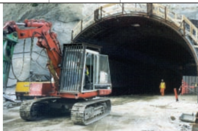
Nouvelle liaison ferroviaire Lyon-Turin : Chantier du tunnel d'accès de Modane (Alain Baron)
