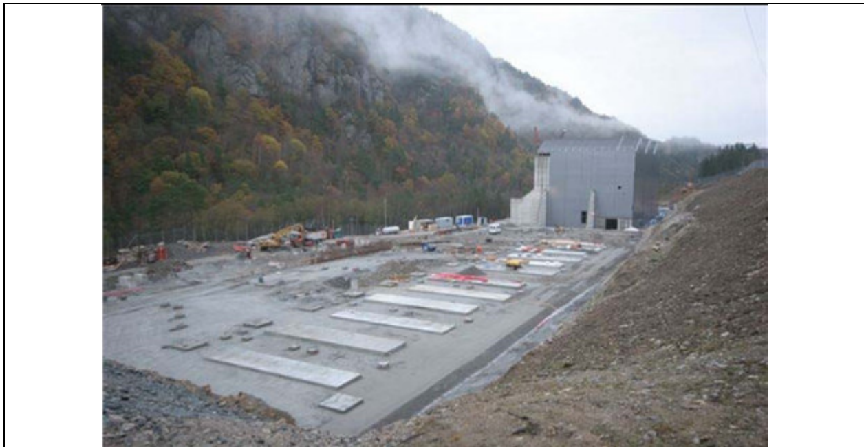
Figure 13: Chantier de construction du poste de conversion de la liaison en courant continu entre la Norvège et les Pays Bas réalisé en 2006
