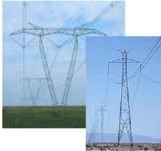
Figure 39 : comparaison d'envergure entre une ligne aérienne en tension alternative et une ligne aérienne en tension continue de même capacité
