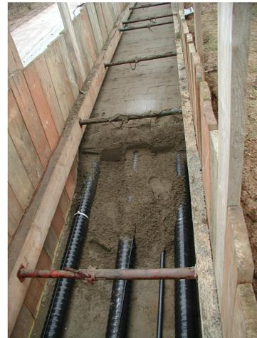
Figure 18 : Pose des câbles en pleine terre- simple tricâble en nappe
