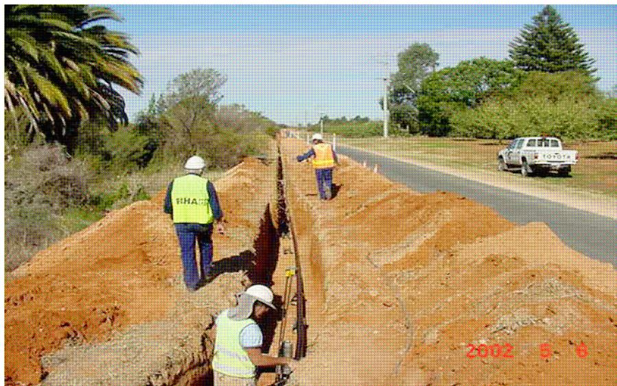
Figure 41 : chantier de pose d'un câble HVDC en Australie
