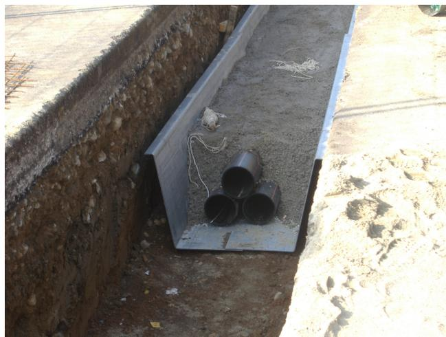
Figure 31: écran magnétique - la configuration montrée fait référence à un tricâble
