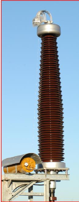
Figure 3 : Extrémité de câble 400 kV
