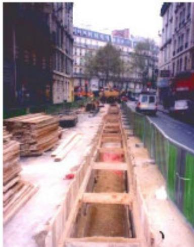
Figure 11 : Tranchée pour la pose de câbles en centre ville – configuration probable simple tricâble en haute tension
