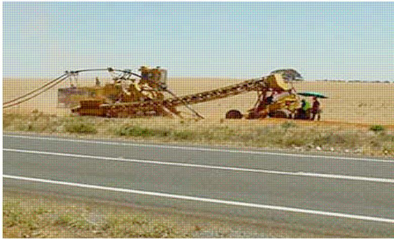
*Figure 42 : utilisation de techniques modernes de pose automatisée dans les zones rurales en Australie*
