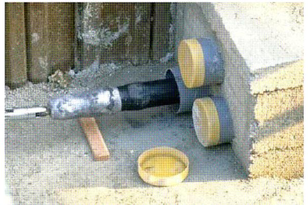
Figure 20 : Tirage de câbles dans les fourreaux – simple tricâble
