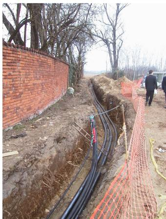
Figure 13 : Tranchée pour pose de câbles en banlieue – simple tricâble en nappe
