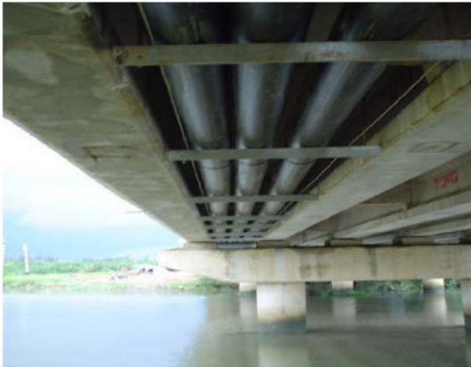
Figure 28 : Pose de câbles intégrés dans la structure d'un viaduc
