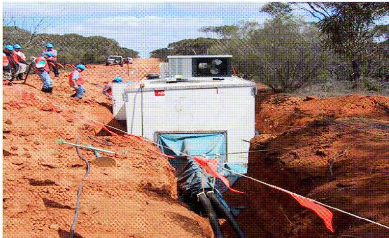
*Figure 43 : structure provisoire pour la réalisation des jonctions*
