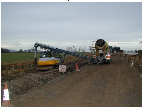
Figure 15 : Ampleur de chantier pour pose d'un double tricâble (source CESI RICERCA 2007)
