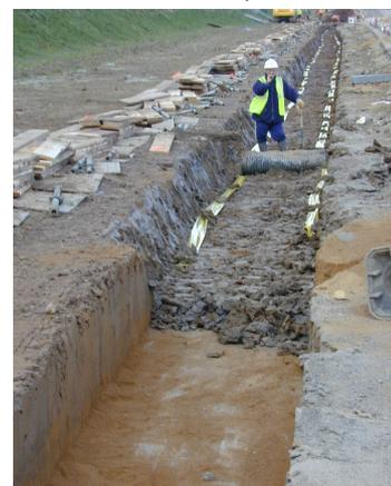
Figure 16 : Aménagement de la base de fourreaux (source RTE 2007)
