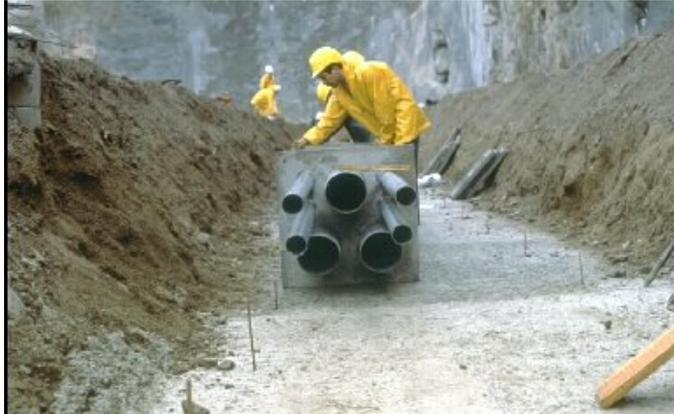
Figure 17 : Dépose de tronçon de fourreaux- simple tricâble en trèfle
