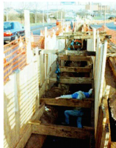
Figure 12 : Tranchée pour la pose de câbles le long d'une route nationale – configuration probable : double tricâble en trèfle
