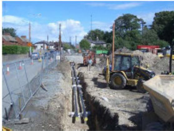
*Figure 10 : Pose d'un double circuit le long d'une route nationale en Italie: réduction des nuisances et utilisation des synergies entre ouvrages (2007)*
