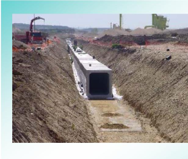
Figure 24 : dépose de la galerie dans la tranchée – connexion de Barajas en Espagne
