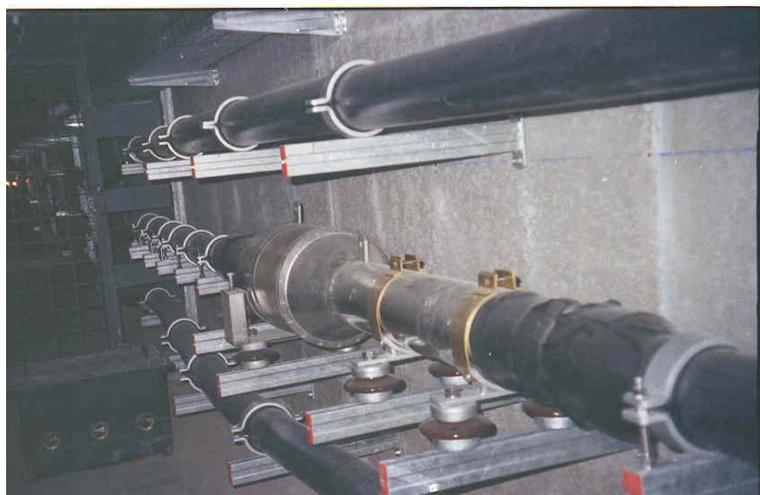
Figura 4 : Unión de cables de muy alta tensión
