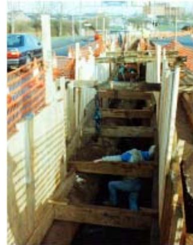
Figura 12 : Zanja para la instalación de cables a lo largo de una carretera nacional – probablemente configuración de tricable doble en trébol
