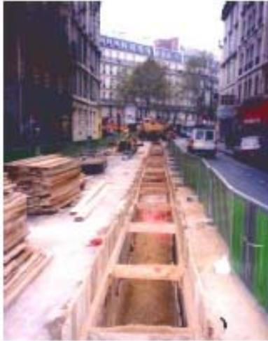
Figura 11 : Zanja para instalación de cables en el centro de la ciudad – probablemente configuración de tricable simple de alta tensión
