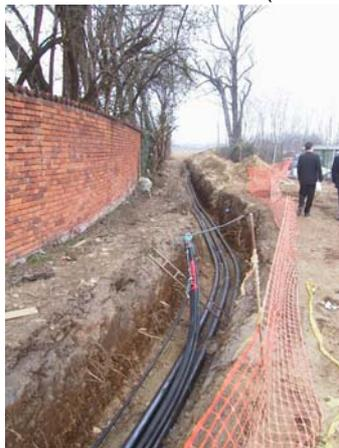
Figura 13 : Zanja para instalación de cables en la periferia de una ciudad – tricable simple en capa
