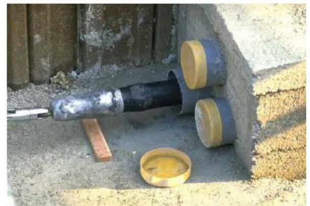
*Figura 20 : Tendido de cables en las cubiertas – tricable simple*
