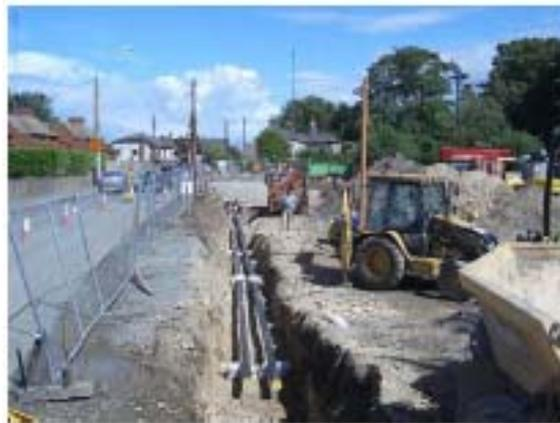
*Figura 10 : Instalación de un doble circuito a lo largo de una carretera nacional en Italia: reducción de las perturbaciones y uso de sinergias entre las construcciones (2007)*
