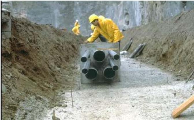
*Figura 17 : Instalación de un tramo de cubierta de tricable simple en trébol*
