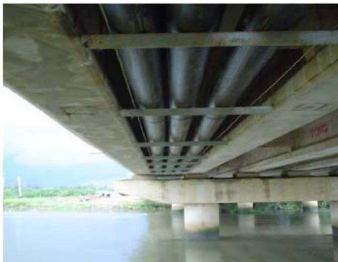
*Figura 28 : Instalación de cables integrados en la estructura de un viaducto*
