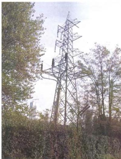
*Figura 37: terminales de cable colgados a un apoyo de línea aérea de alta tensión a 130kV*
