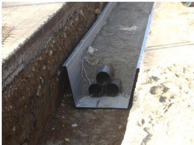
Figura 31: pantalla magnética – la configuración mostrada es de un tricable
