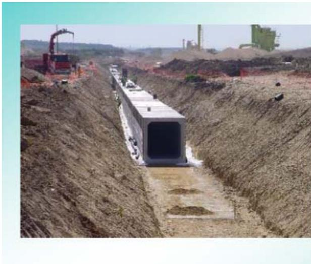
*Figura 24 : colocación de la galería en la zanja – conexión de Barajas en España*
