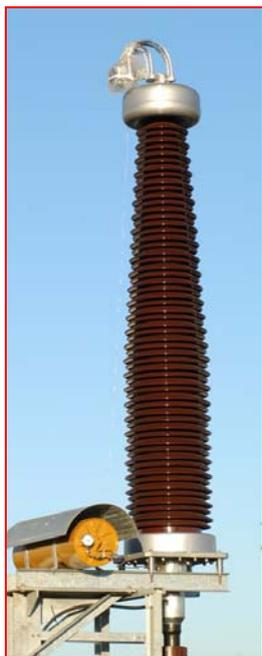
Figura 3 : Terminal de cable 400 kV
