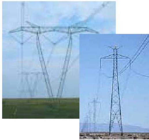
*Figura 39: comparación de envergadura entre una línea aérea en corriente alterna y una línea aérea en corriente continua de la misma capacidad*
