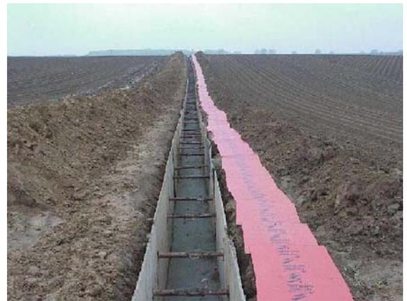
Figura 14 : Zanja en terreno raso – tricable simple
