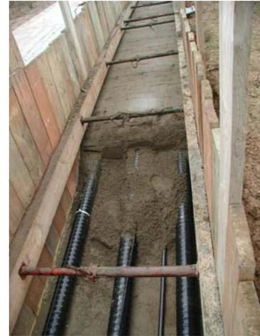
*Figura 18 : Instalación de los cables directamente sobre tierra – tricable simple en capa*
