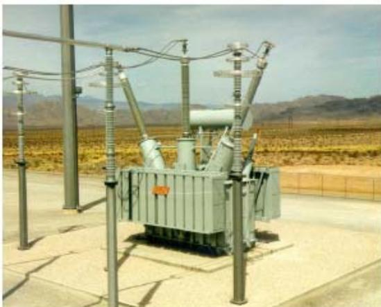
*Estación de compensación 400 kV 160 MVA*
