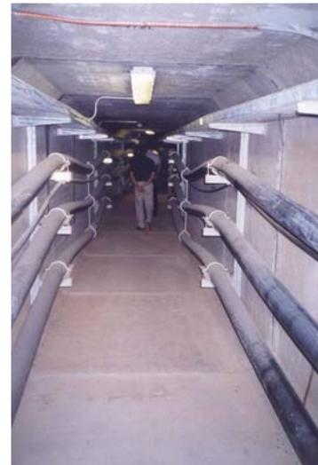
*Figura 25 : vista interior de la galería de la conexión de Barajas en servicio*
