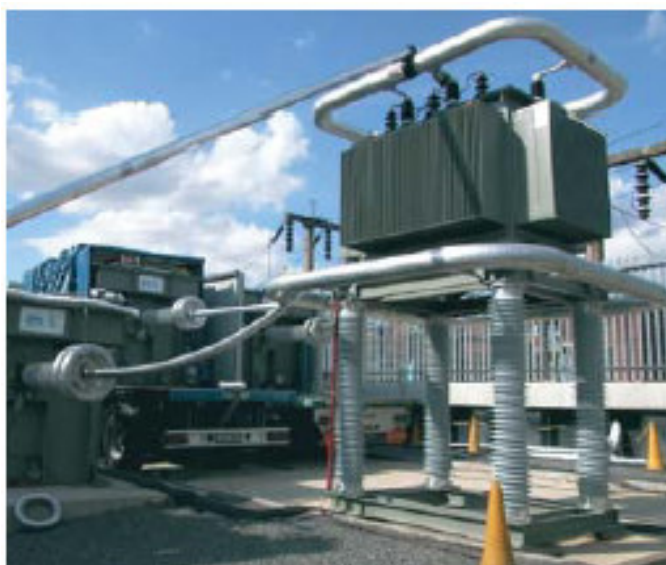
Figure A35 : essai de mise en service du câble du projet ELSTREE
