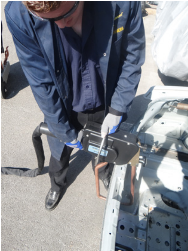
Obrázok 6.1 Ručná bodová zväračka používaná na pripevnenie nového panelu
