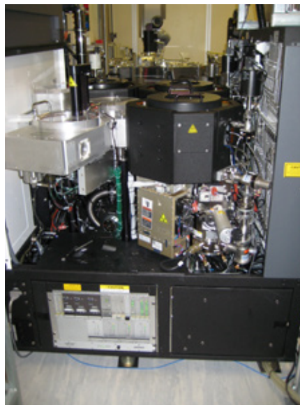
Figura 9.2. – Camere de reacție în zona de service
