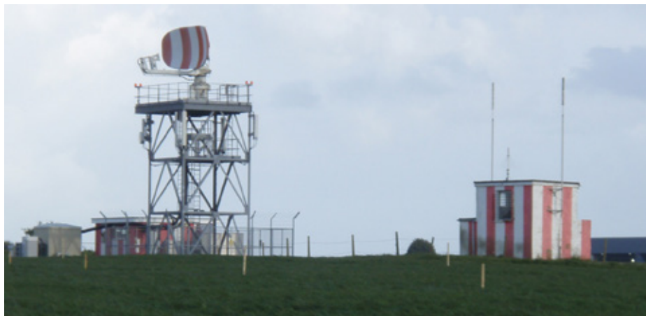
Figura 12.1. – Exemplu de sistem radar de supraveghere pentru aeroport
