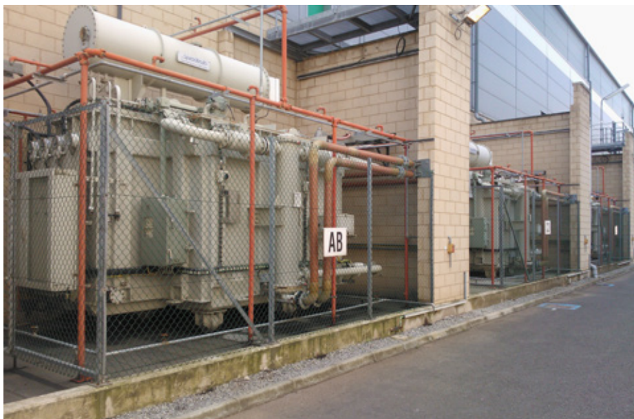
Figura 3.4. – Locașurile transformatoarelor
