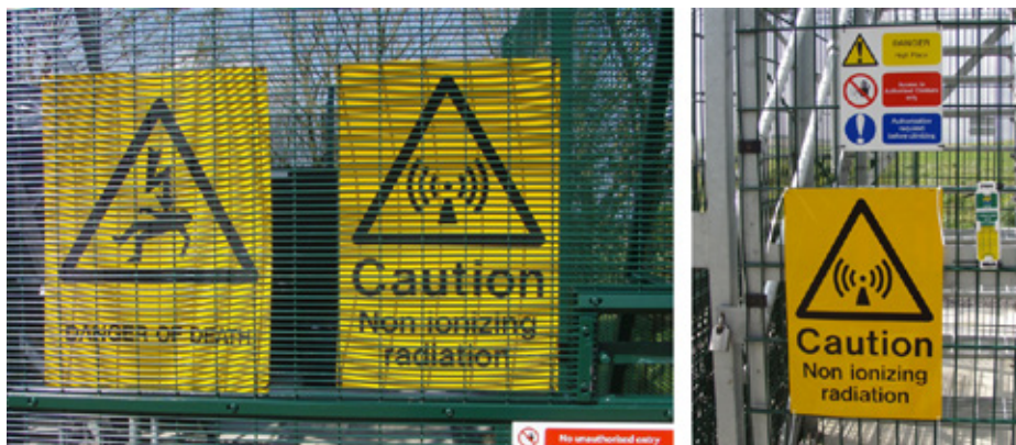
Rysunek 12.4 – Ostrzeżenia umieszczone na bramie wejściowej na ogrodzony teren, na którym znajdował się radar (z lewej), i na bramie wejściowej klatki schodowej wieży antenowej (z prawej)
