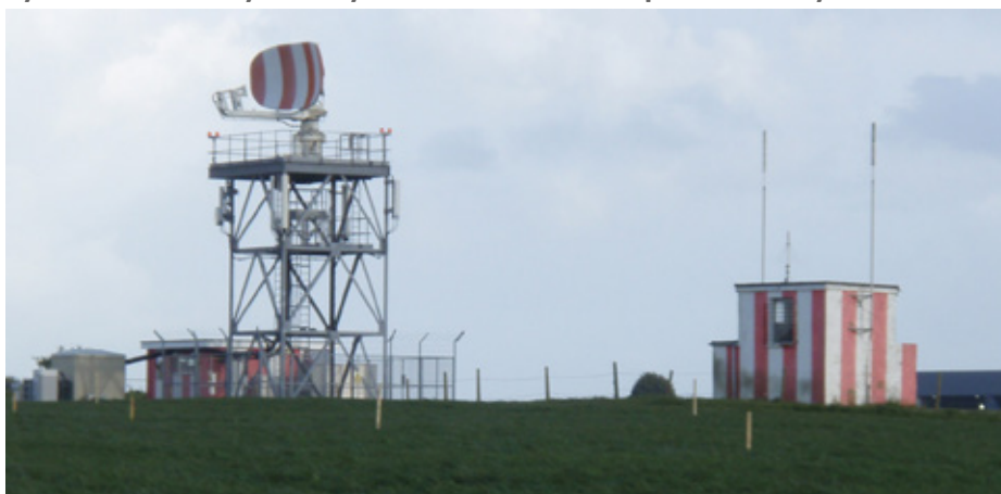
Rysunek 12.1 – Przykładowy radar dozoru w porcie lotniczym
