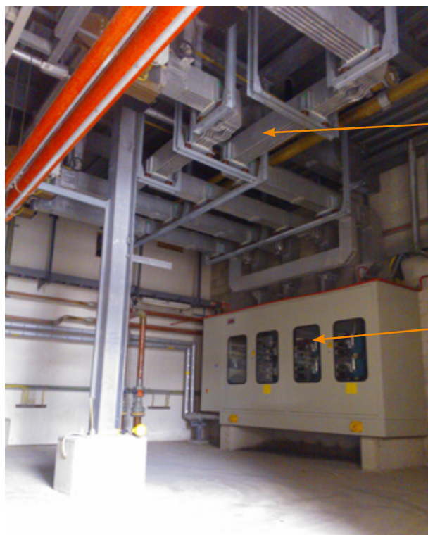
Rysunek 3.3 – Ograniczenie dostępu do komory szafy zespołu prostownikowego
