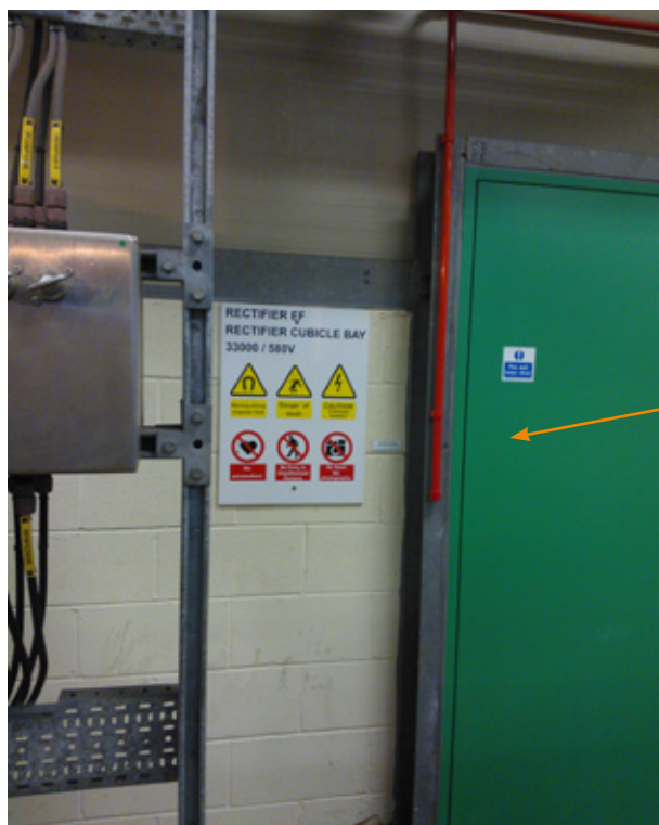
Rysunek 3.3 – Ograniczenie dostępu do komory szafy zespołu prostownikowego
