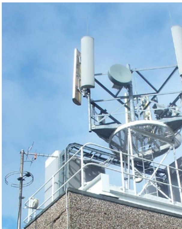
Figura 10.1 L-antenni tas-settur tal-mowbajls u d-dixx tal-majkrowejv fuq il-bejt tal-lifthouse
