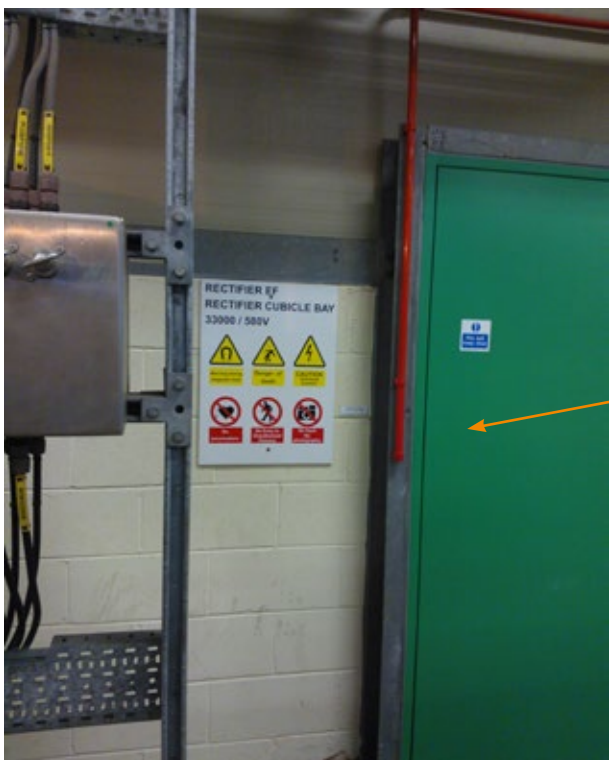
Figura 3.3 Restrizzjoni tal-aċċess għal żona tal-cubicle tar-rettifikatur
