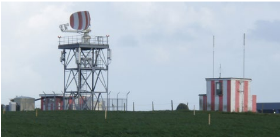
Figura 12.1 Eżempju ta' radar ta' sorveljanza tal-ajruport
