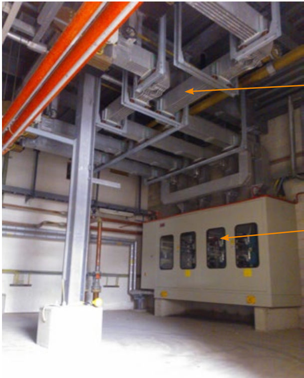
Figura 3.3 Restrizzjoni tal-aċċess għal żona tal-cubicle tar-rettifikatur
