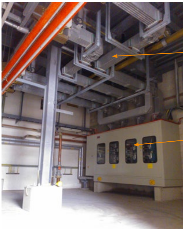
3.3. attēls. Piekļuves taisngriežu kamerai ierobežojums
