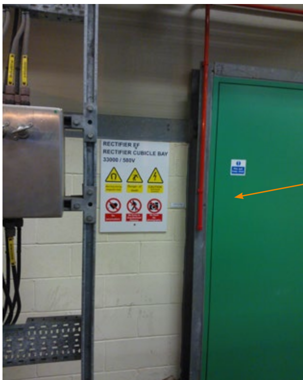
3.3. attēls. Piekļuves taisngriežu kamerai ierobežojums
