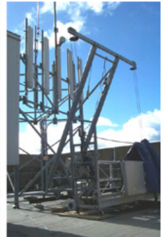
(c) košara za pranje prozora koja se više ne može podići ispred antena
