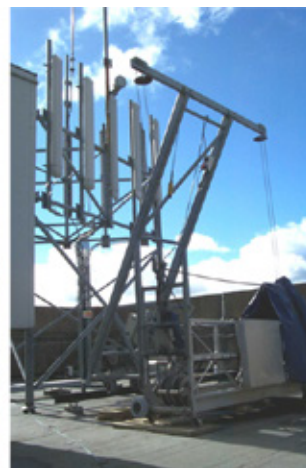
c) La nacelle des laveurs de vitres ne peut plus se retrouver en face des antennes
