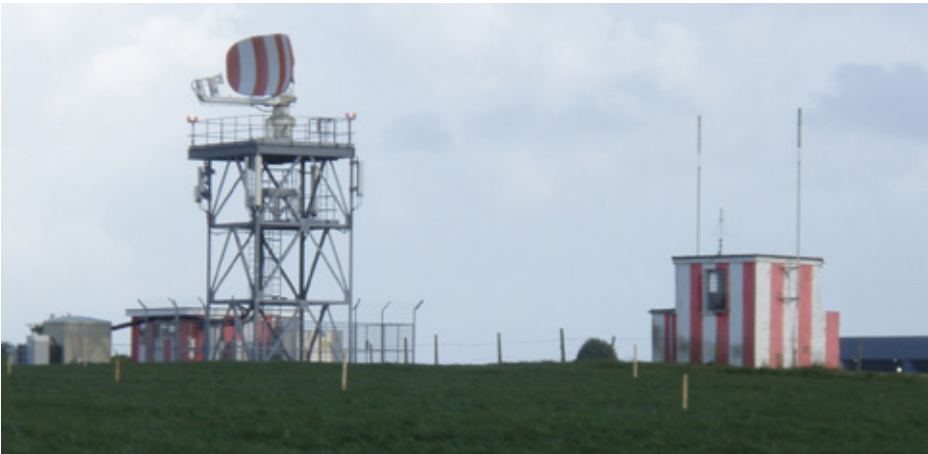
Illustration 12.1 — Exemple de radar de surveillance d'aéroport
