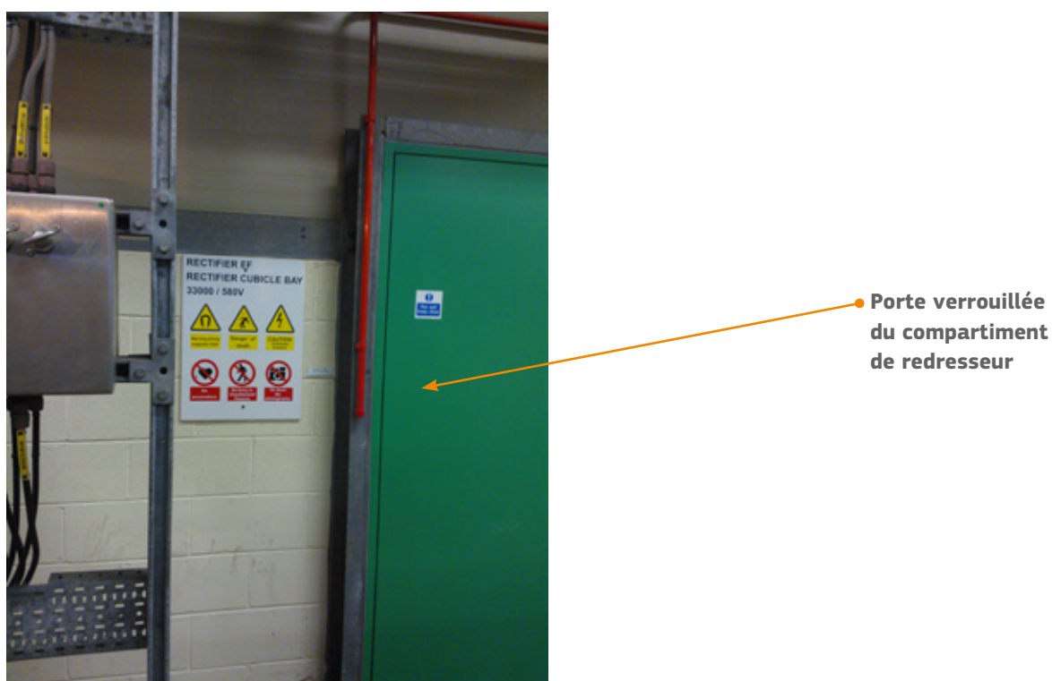
Illustration 3.3 — Restriction de l'accès à un compartiment de redresseur
