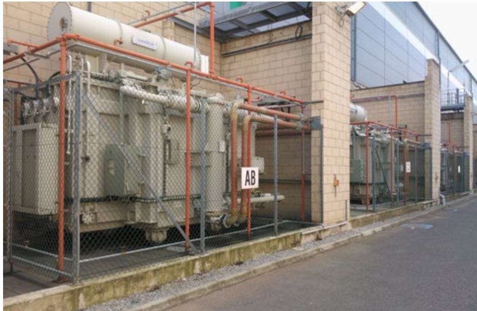
Figur 3.4. Transformatorbåse
