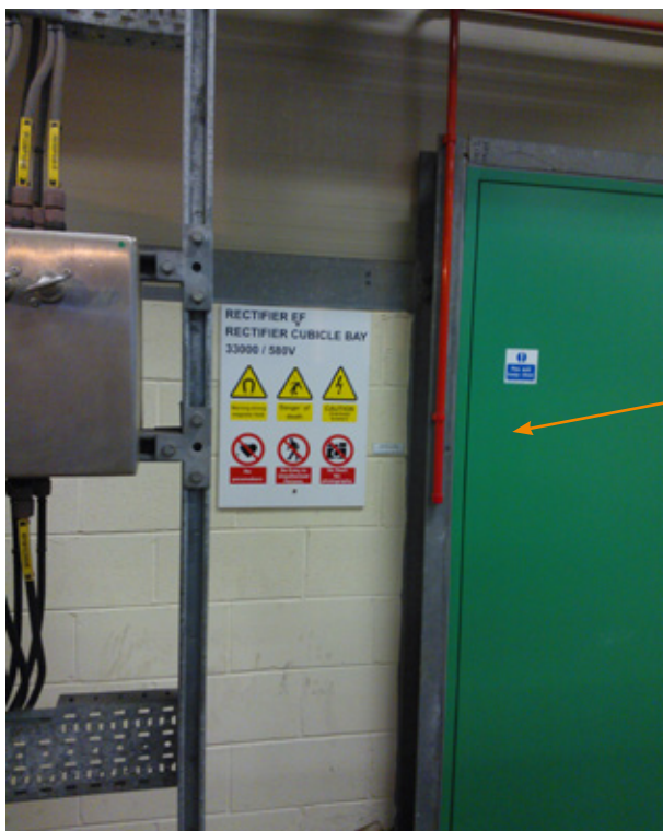
Obrázek 3.3 Omezení přístupu do kóje s usměrňovačem
