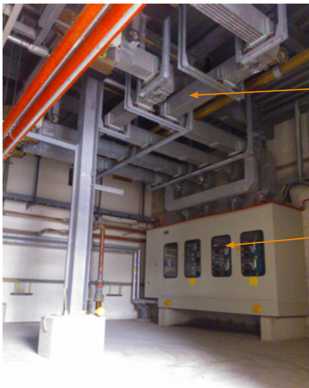
Obrázek 3.3 Omezení přístupu do kóje s usměrňovačem
