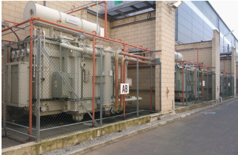
Obrázek 3.4 Transformátorové kóje
