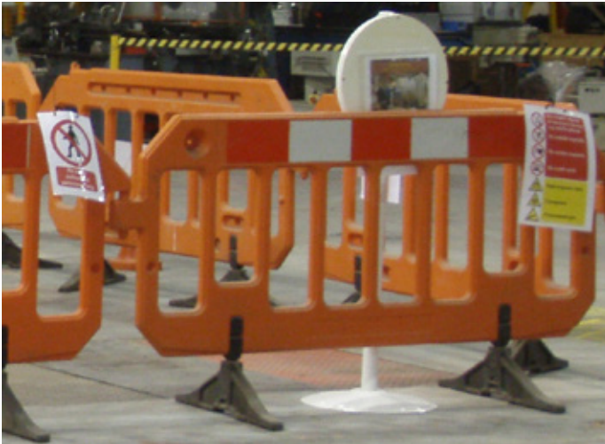
Obrázok 9.5 Dočasné zábrany a výstražné značky na obmedzenie prístupu do silných polí vytváraných dočasnou inštaláciou
