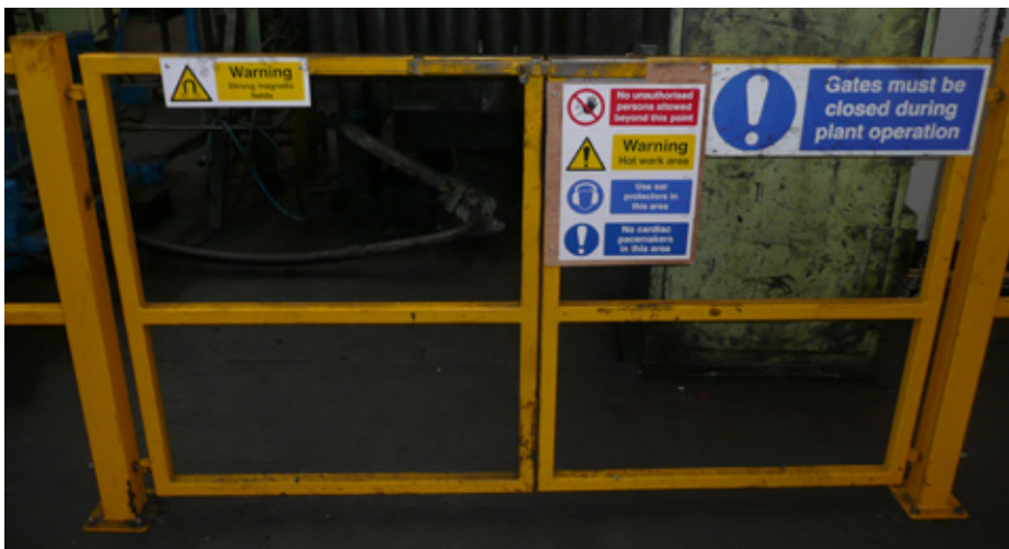
Figura 9.1 — Eżempju ta' lqugħ ta' protezzjoni sempliči mobbli użat sabiex jillimita l-aċċess għal kamp manjetiku b'saħħtu. F'dan il-każ, il-protezzjoni ma fihix mekkaniżmu awtomatizzat ta' llokkjar, iżda hija ssupplimentata minn sinjali ta' twissija u miżuri organizzazzjonali
