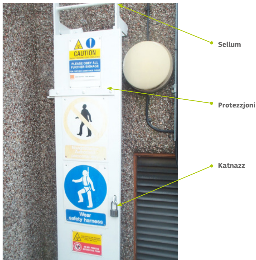
Figura 9.2 — L-użu ta' protezzjoni għas-sellum sabiex jiġi limitat l-aċċess għal kampi b'saħħithom fuq il-bejt
