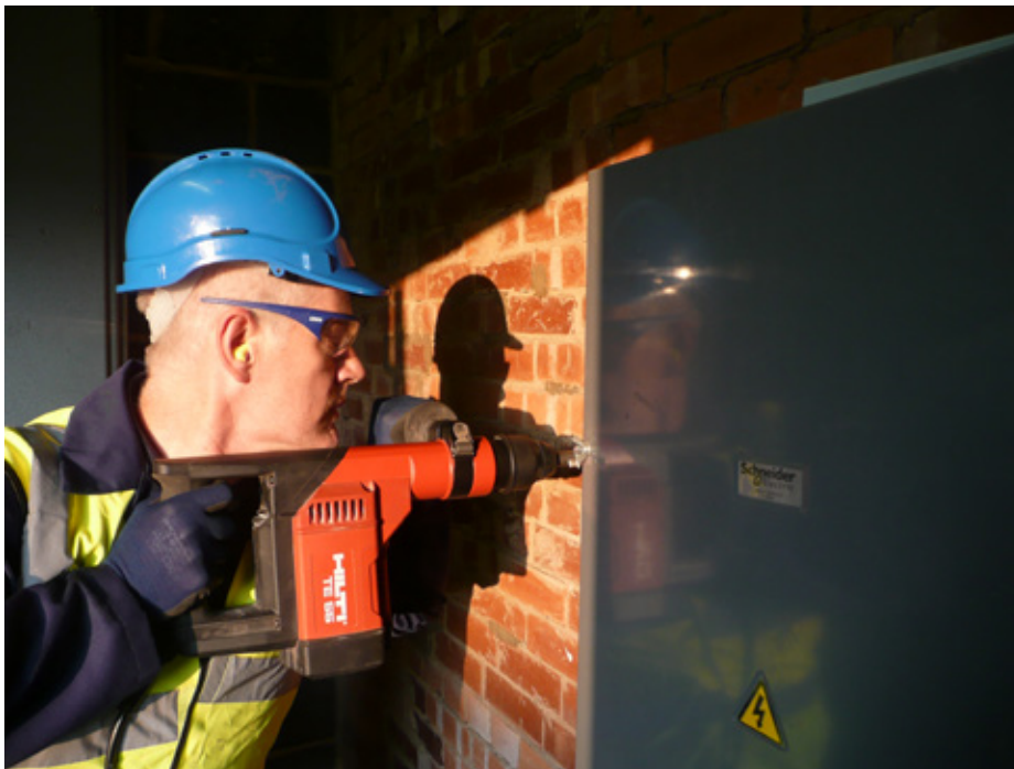
Figura 6.5 — Ħaddiem iżomm għodda elettrika qrib ġismu. F'din is-sitwazzjoni, l-esponiment tal-ġisem u d-dirgħajn u r-riglejn u l-konformità mal-ALS baxxi/għoljin ser ikunu limitattivi
