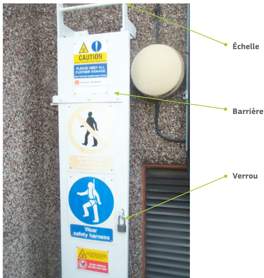
Illustration 9.2 — Utilisation d'un protecteur d'échelle pour limiter l'accès à des champs puissants sur un toit
