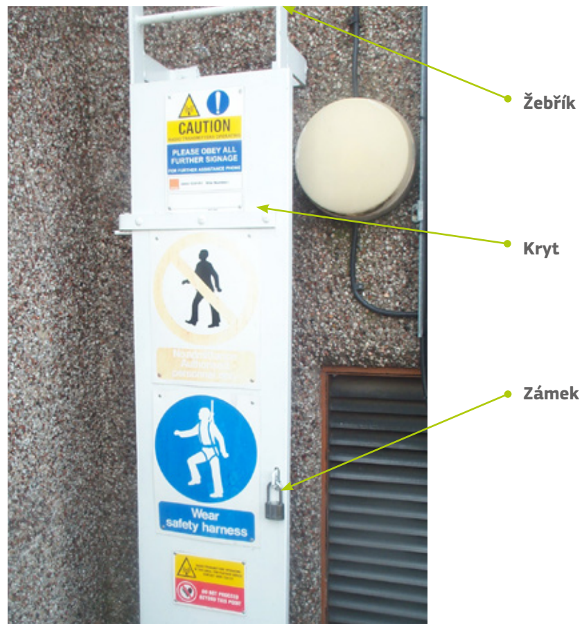
Obrázek 9.2 Použití krytu žebříku pro omezení přístupu k silným polím na střeše
