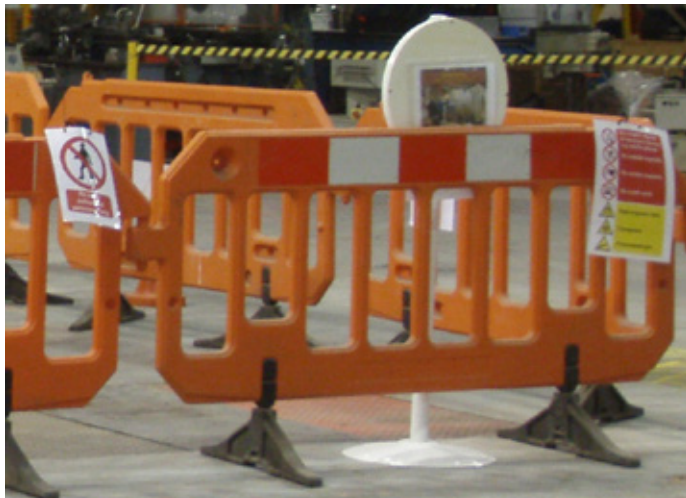
Obrázek 9.5 Dočasné zábrany a výstražné značky omezující přístup do silných polí vytvářených dočasným zařízením
