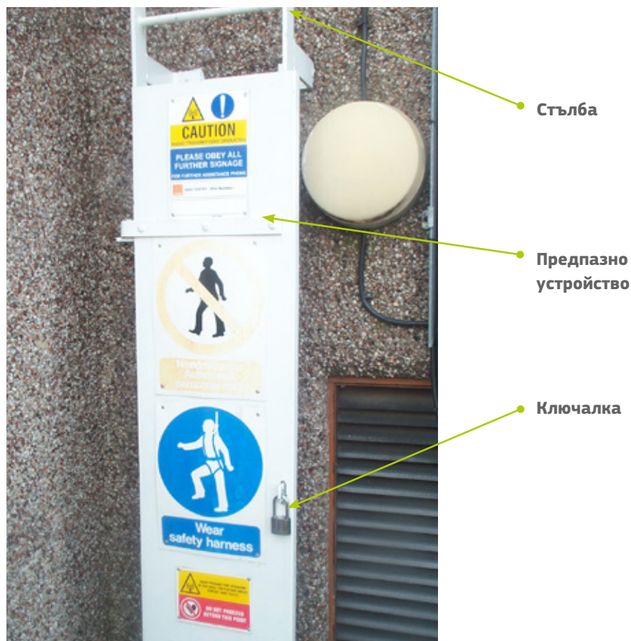
Фигура 9.2 — Използване на предпазно устройство на стълба за ограничаване на достъпа до силни полета на покрива
