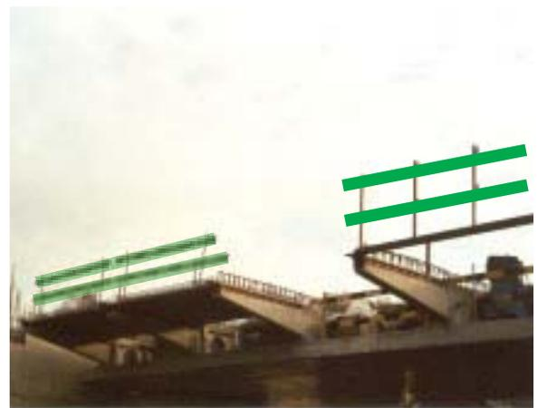
Utilización de una canasta telescópica para la colocación de protecciones contra las caídas antes de la colocación de las losas de hormigón
