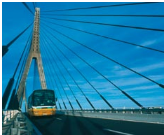
Most na rzece Guadiana łączący Hiszpanię i Portugalię, Algarve, Portugalia.
