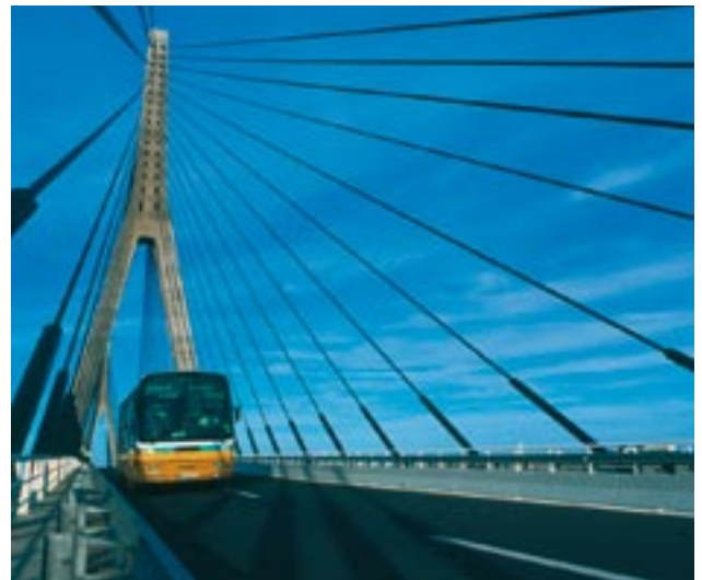
Die Brücke über den Rio Guadiana (Algarve, PT) verbindet Spanien und Portugal.
