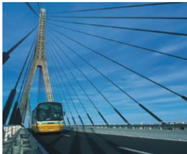
Most přes řeku Guadiana v portugalské provincii Algarve, který spojuje Španělsko a Portugalsko.
