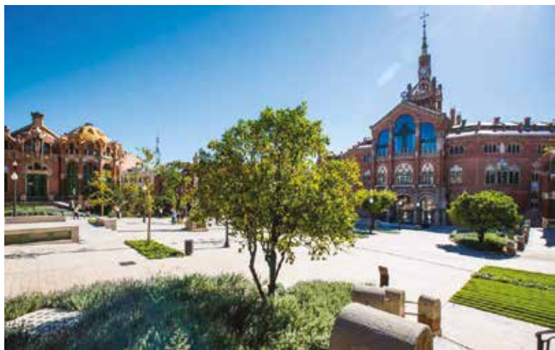
Vista del pabellón de administración (lado norte), jardines interiores y patio. El Hospital de Sant Pau ha sido renovado con fondos del FEDER.
