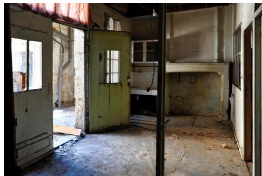
Ilustración 4. Vivienda por renovar, antes, Jérémie Buchholtz
