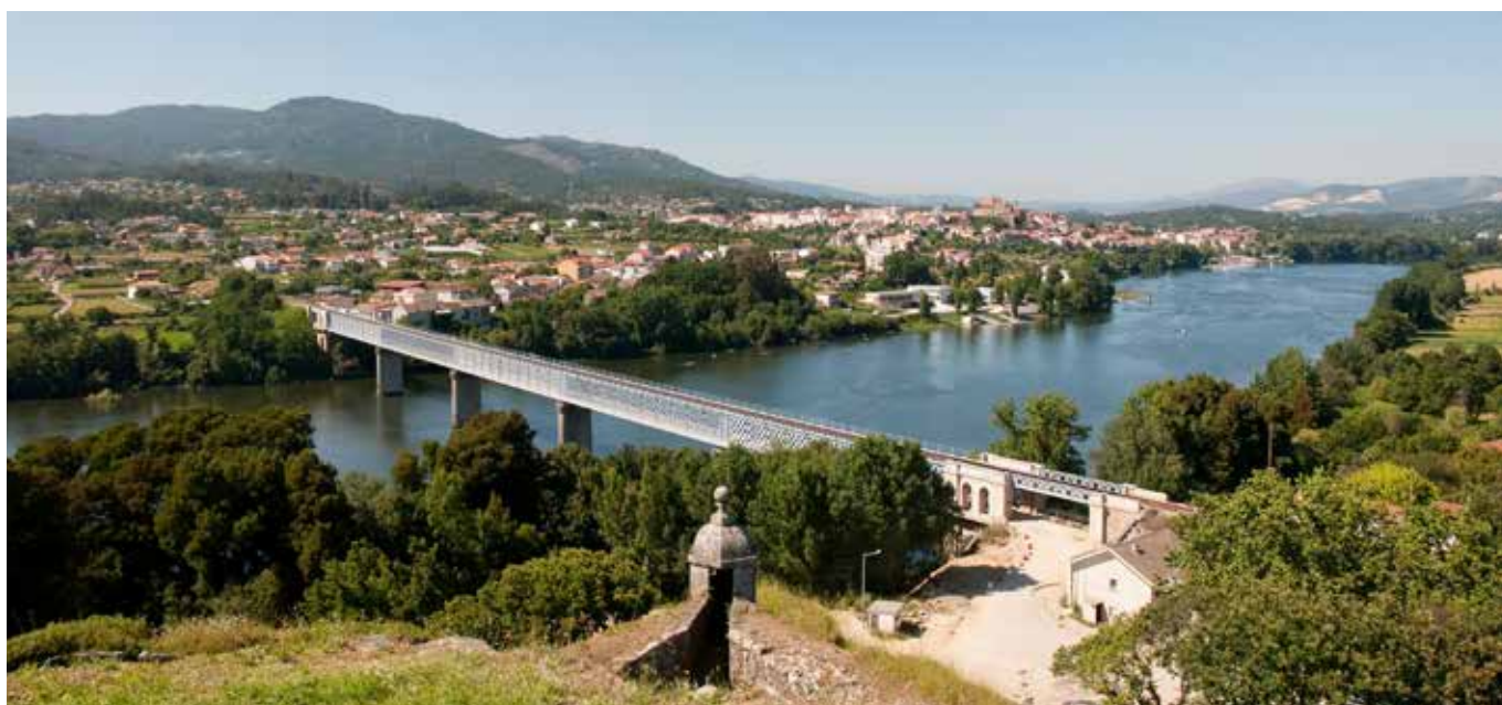
A ponte sobre o rio Minho, que liga Tui, em Espanha, a Valença do Minho, em Portugal
