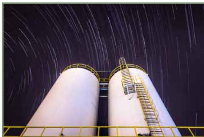
Zvaigžņota debess aiz dehidrēto dūņu tvertnēm Bareiro/Moitas notekūdeņu attīrīšanas iekārtā Portugālē — Eduardo Ventura
