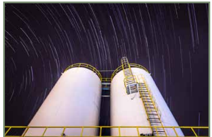
Trainées d'étoiles derrière des silos de boue déshydratée à la station d'épuration des eaux usées de Barreiro/Moita, Portugal – Eduardo Ventura
