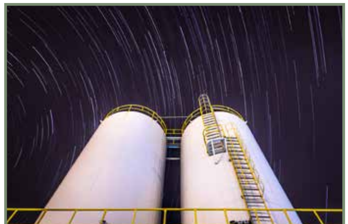
Rastros de estrellas en un silo de barro deshidratado en la depuradora de aguas residuales de Barreiro/Moita, Portugal – Eduardo Ventura
