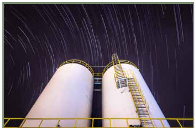
Stjerners baner bag siloer til dehydreret slam på spildevandsrensningsanlægget i Barreiro/Moita, Portugal – Eduardo Ventura
