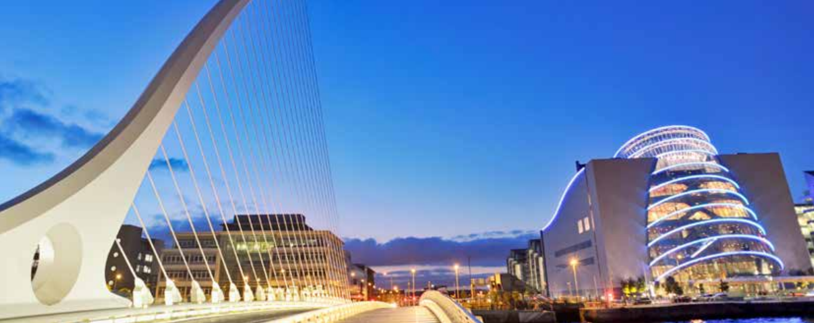
Puente Samuel Beckett, Dublín
