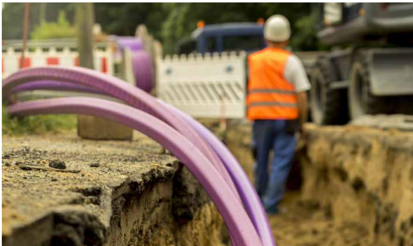
Aanleg van een glasvezelnetwerk - een aanzienlijke investering in de Franse regionale infrastructuur.
