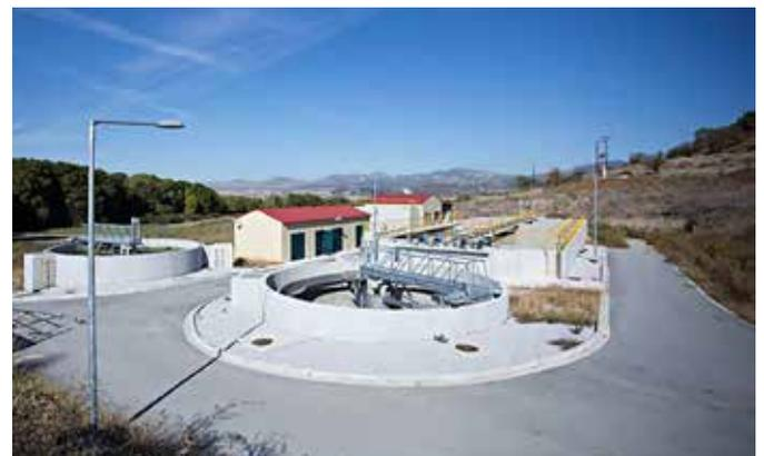
Questo progetto, che ha la capacità di servire 7500 abitanti, è attualmente in fase di prova. Il trattamento delle acque reflue viene effettuato utilizzando il processo di fanghi attivi in aerazione prolungata, con stabilizzazione simultanea dei fanghi e nitrificazione parallela, denitrificazione e disidratazione dei liquami. Il progetto è finanziato dal programma operativo «Ambiente e sviluppo sostenibile».
