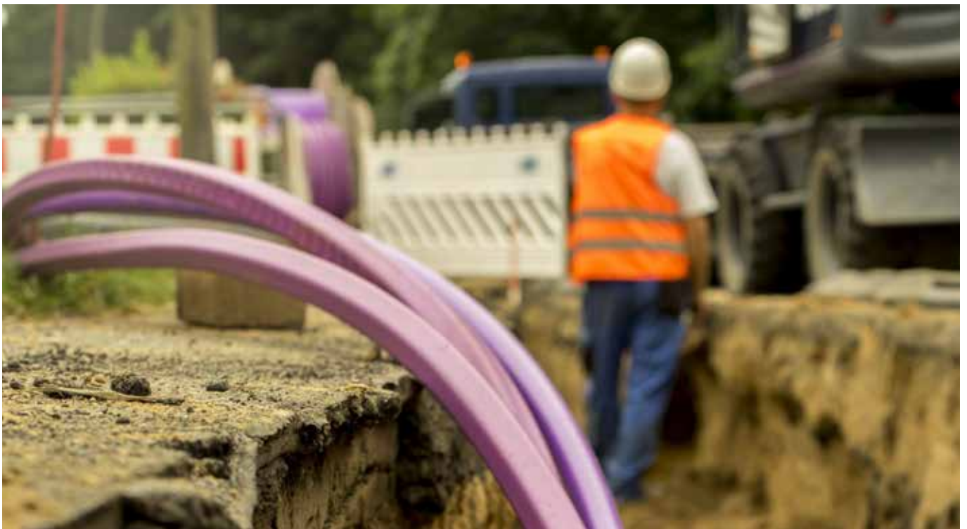
L'installation d'un réseau de fibre optique – un investissement majeur dans l'infrastructure régionale française.
