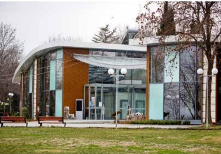
^ Außenansicht auf das Ausstellungszentrum Flora in Burgas
