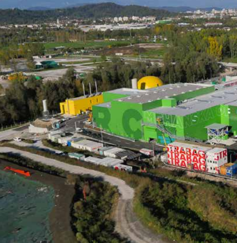
↗ Regionalne Centrum Gospodarki Odpadami w Lublinie wspomaga recykling i zrównoważone zbieranie odpadów
