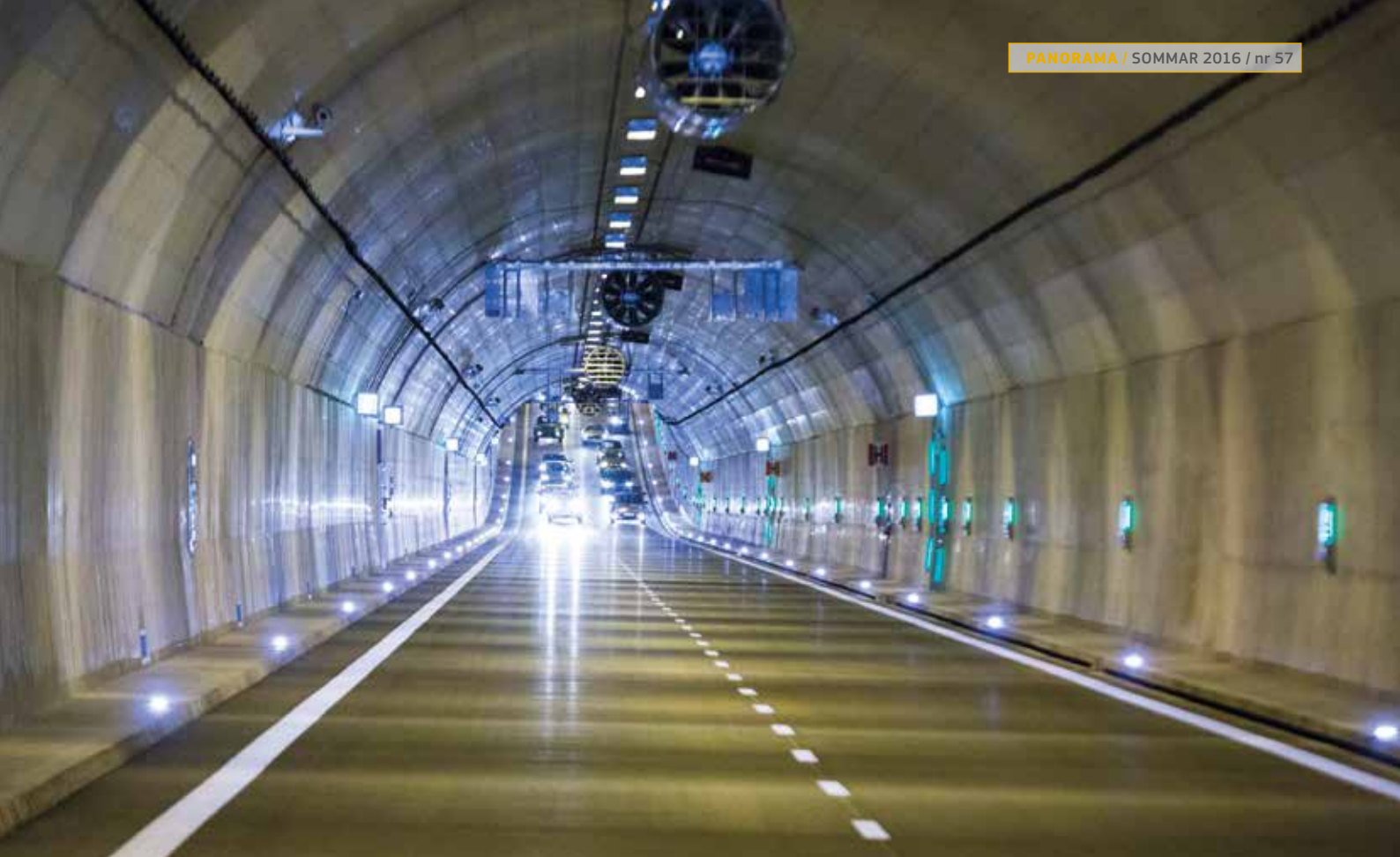
Rörtunnel under Martwa Wisla
