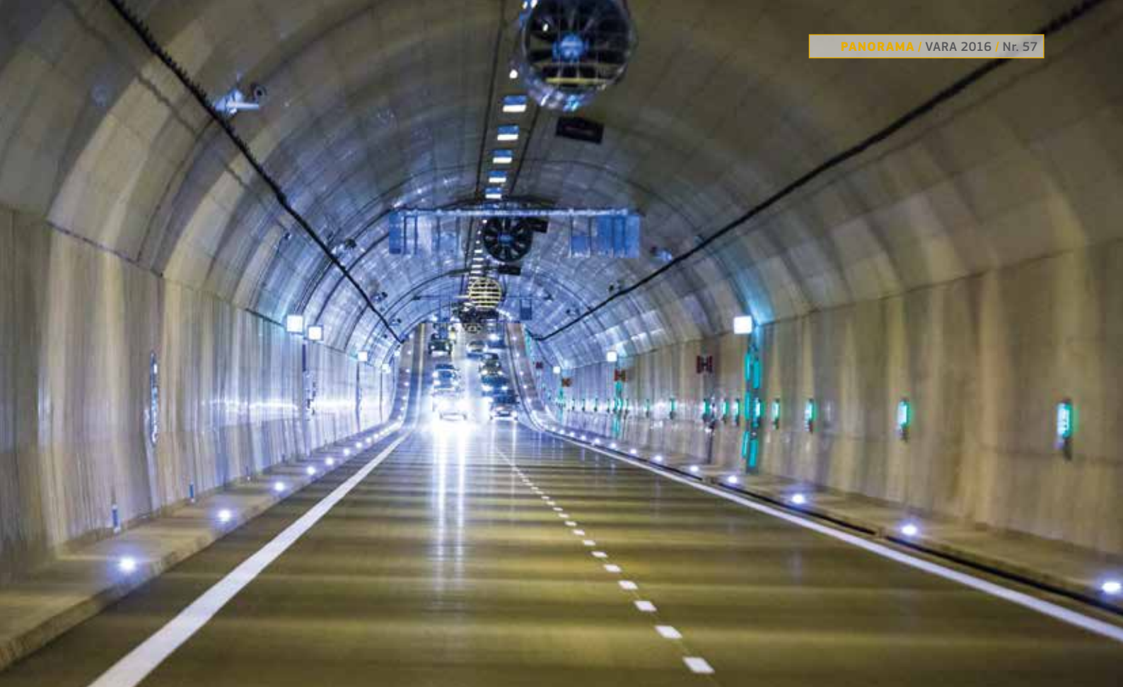
Tunel cu o galerie sub Martwa Wisla
