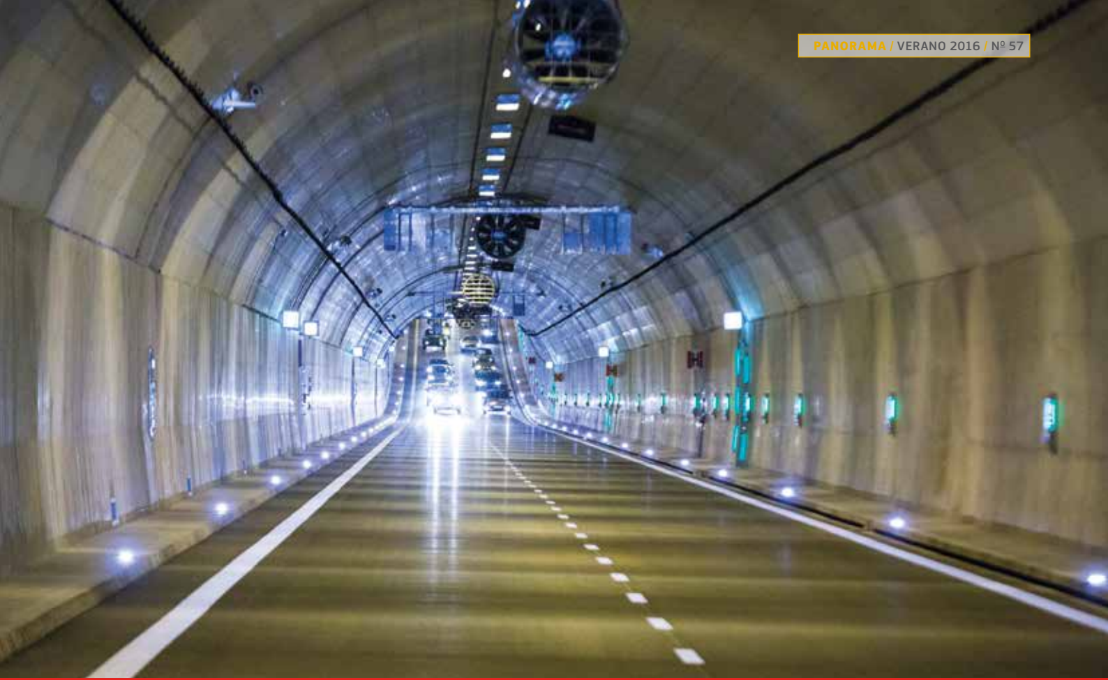
Túnel de tubo bajo el río Martwa Wisła
