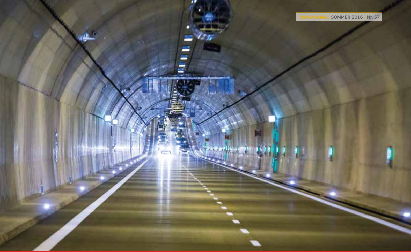
Röhrentunnel unter dem Martwa Wisla
