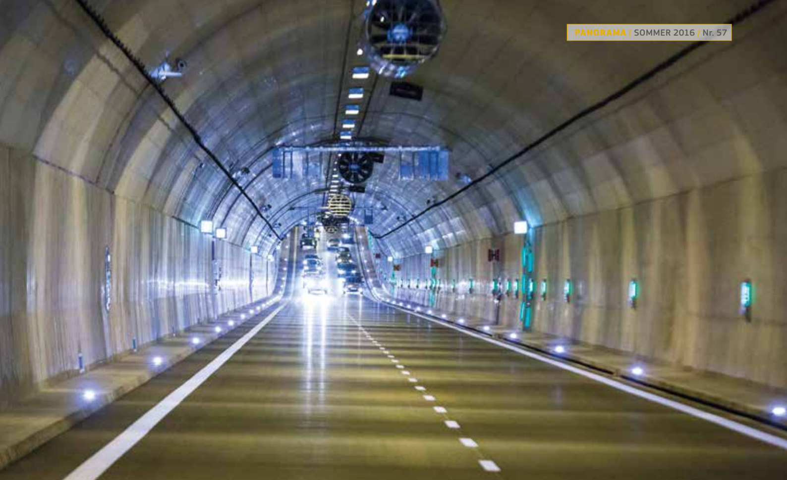
Rørtunnel under Martwa Wisła
