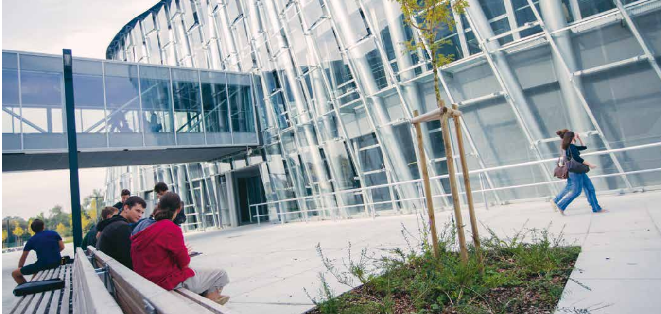
▶ LIUBLIANA, ESLOVENIA: Las nuevas instalaciones para la Facultad de Química y de Tecnología Química y la Facultad de Informática y Ciencias de la Información han reforzado la capacidad de investigación en los ámbitos de ciencias naturales y tecnología.
