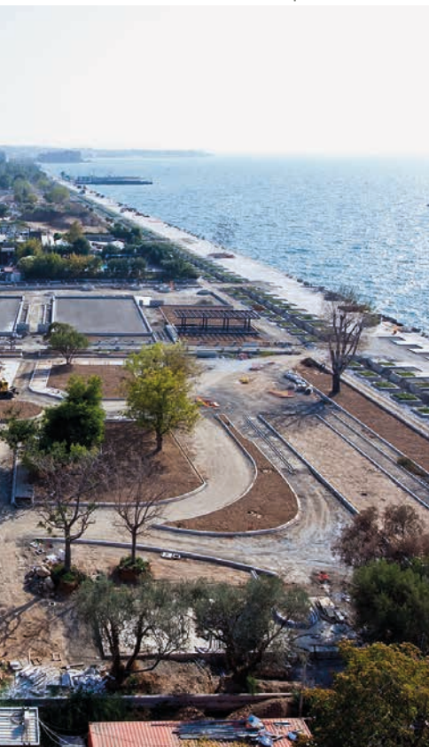
▶Risanamento del lungomare di Salonicco, seconda città della Grecia per dimensioni.
