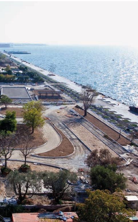
► Sanierung der Strandpromenade von Thessaloniki, der zweitgrößten Stadt Griechenlands.
