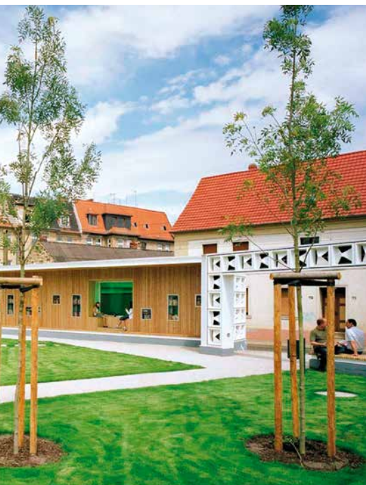
► Offentligt friluftsbibliotek i Magdeburg, Tyskland.
