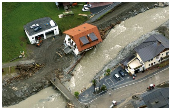
▶Powódź spowodowała ogromne zniszczenia w Austrii w 2005 r.
